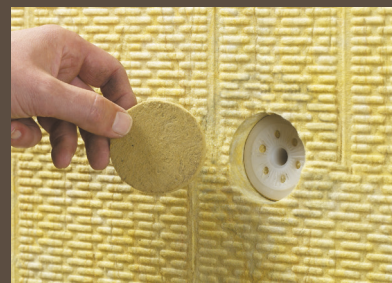
Monter isoleringsrondellen.
