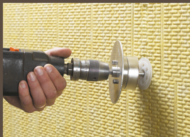
Skrue og fræs dyvlen ind i isoleringen i én arbejdsgang.
